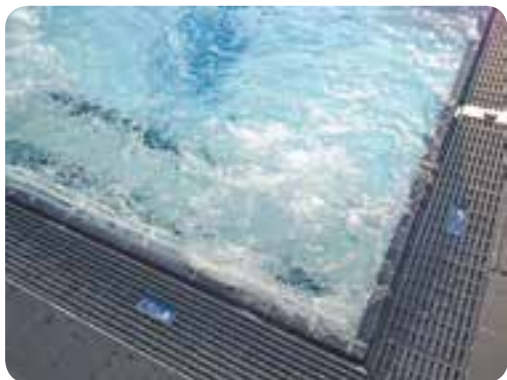
La goulotte est posée sur un châssis en Inox 441 revêtu de PVC laminé à chaud (Pool's - Proteus)
