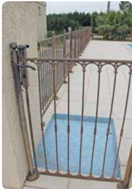
Portillon aux normes et pédiluve à l'entrée. Douche sur la plage.
