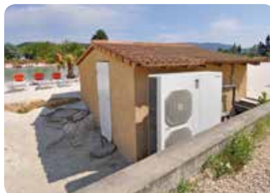
Une des pompes à chaleur Zodiac
