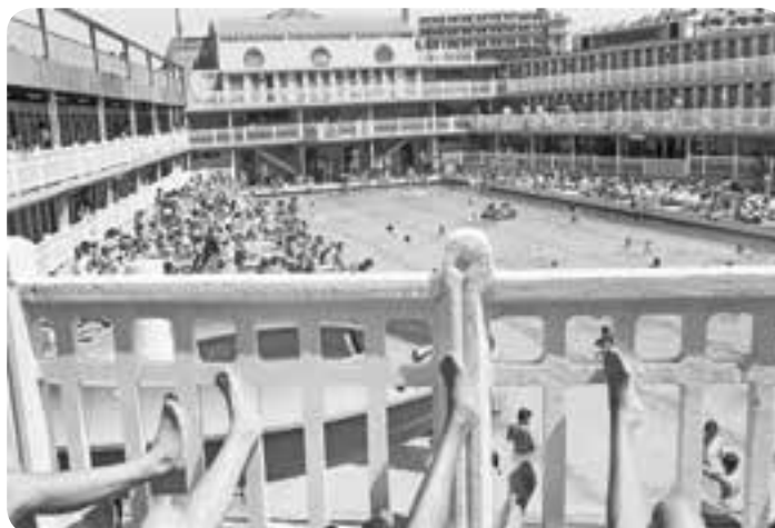
Molitor à la grande époque ! L'hiver, ce grand bassin extérieur se transformait en patinoire.
