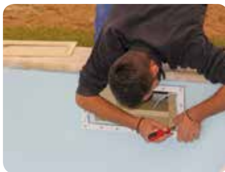
Après la pose d'une membrane armée, mise en place d'une bride d'étanchéité sur les skimmers.
