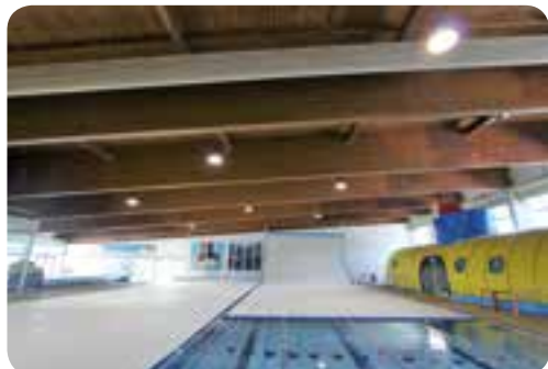
Piscine publique avec couverture en mousse et volets automatiques fixés au mur Thiene (ITA)
