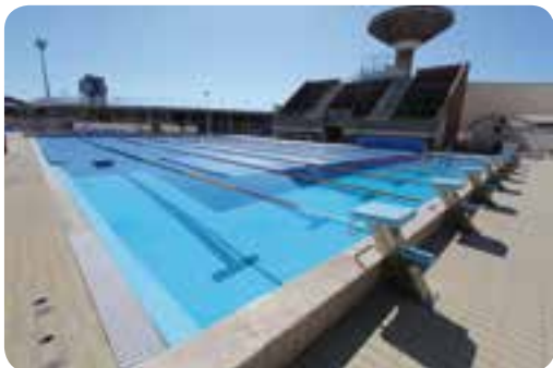
Piscine municipale de Latina, Rome, (ITA) - couverture de piscine.
