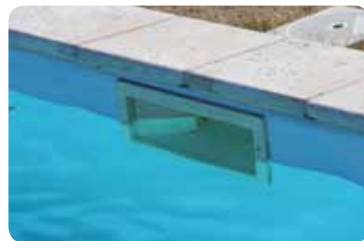
Dans cette piscine de collectivité, les skimmers à meurtrière disposent d'une bride d'étanchéité, indispensable au revêtement d'étanchéité en membrane armée.
