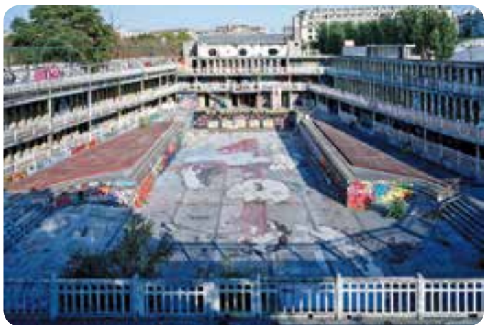
Le résultat de 25 ans d'abandon et d'importantes dégradations.
