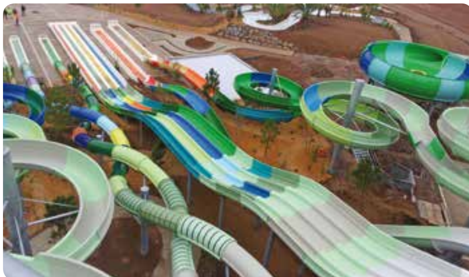
En plein chantier, cette conception utilise la solution aquafrein et se dispense donc de bassin de réception. Réalisation Edsun Loisirs - O'Gliss Park, Le Bernard (85).
