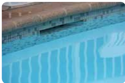
Dans cette piscine d'hôtel, ce revêtement en pâte de verre réalisé sur un béton projeté étanche avec skimmer spécial béton, n'a pas nécessité de joint supplémentaire.
