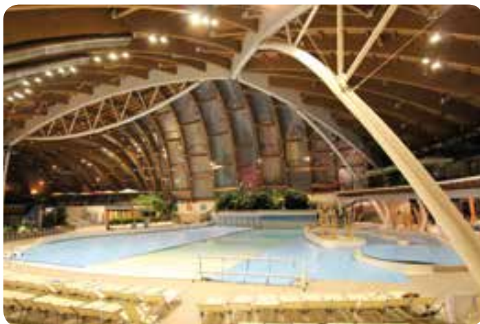
Le plus grand parc aquatique couvert italien : AQUAWORLD, Milan (ITA) - Couvertures à rétention de chaleur, de forme libre, avec système volet manuel ou automatique.
