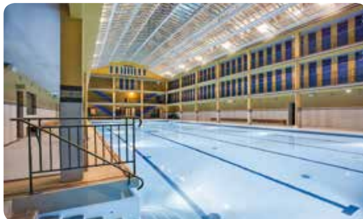
Le bassin d'hiver de 33 mètres, avec sa verrière entièrement reconstruite, en cours de travaux, puis finalisée.
