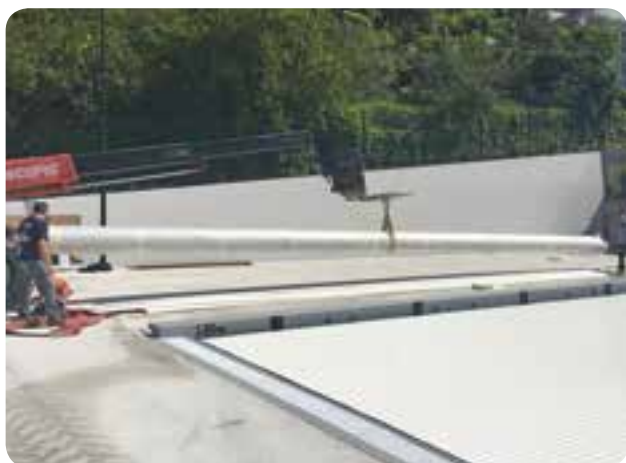
Déchargement de la couverture
