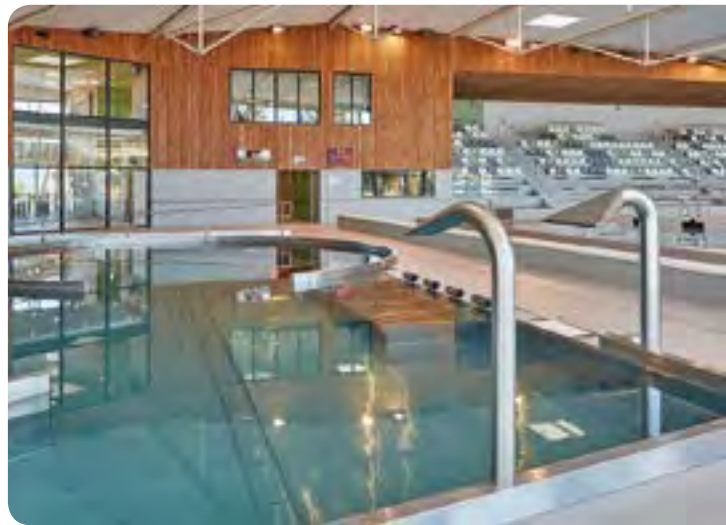
Utilisation générale de l'inox pour la structure des bassins intérieurs et de celui de l'extérieur.
