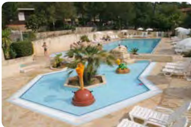
Création de 27 m 2 de pataugeoire sur le camping LES PINEDES (06). Peu de place mais un besoin de proposer un bassin pour les enfants sans dénaturer un espace piscine existant intégré dans le relief du camping.
