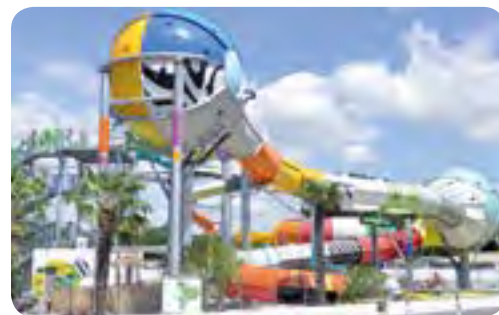
Camping Le Château à Saint-Hilaire-de-Riez (85) Réalisation Edsun Loisirs
