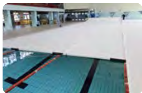
Piscine municipale de Reggio Emilia (12 x 25 m). Couverture isotherme Multi55 WHT et enrouleur motorisé mobile MNR sans fil (batterie), réalisé entièrement en acier inoxydable 316L.
