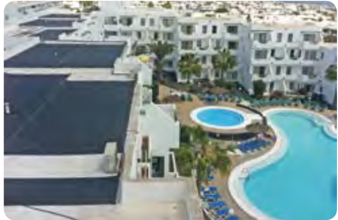
Les îles Canaries - 64 panneaux solaires pour la grande piscine, 8 pour la piscine pour enfants
