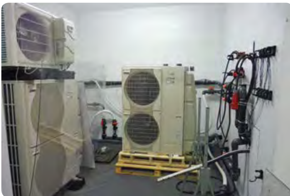
Des pompes à chaleur au banc d'essais
