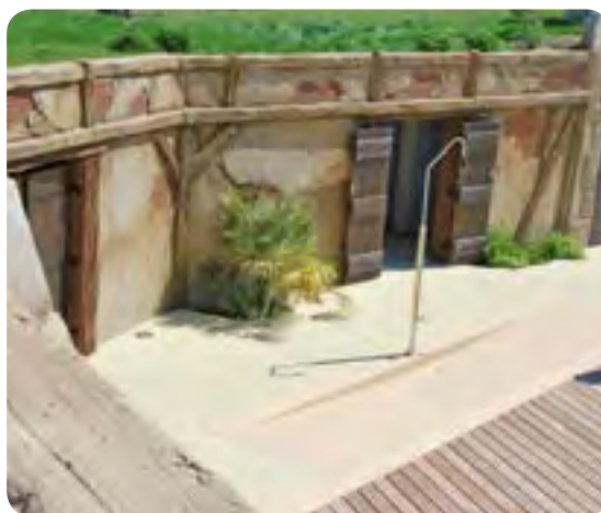
Réalisation de la totalité de la façade du camping village Eskualduna
