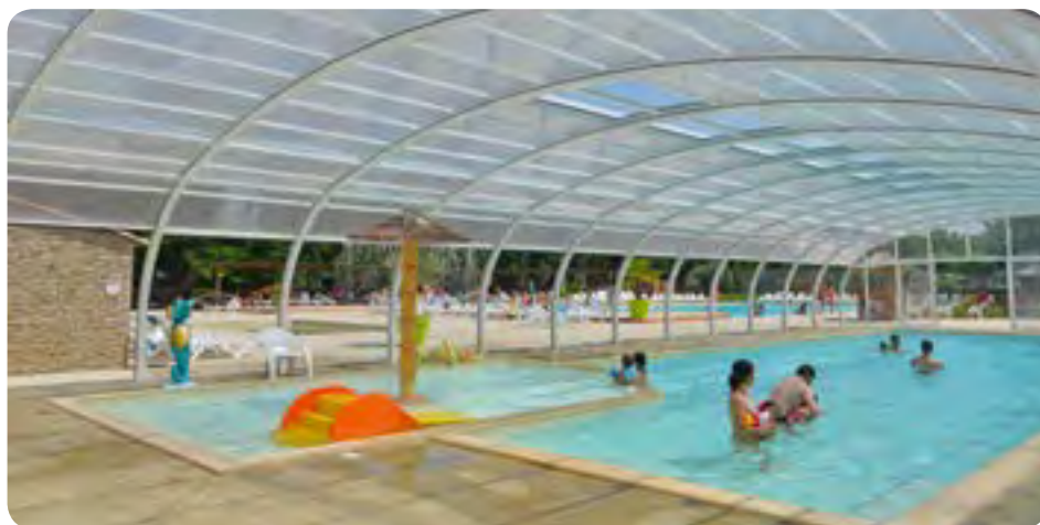
Piscine couverte et sa pataugeoire adjacente - Camping Verdon Parc Réalisation Piscine & Carrelage d'Aquitaine - Abri Vegametal
