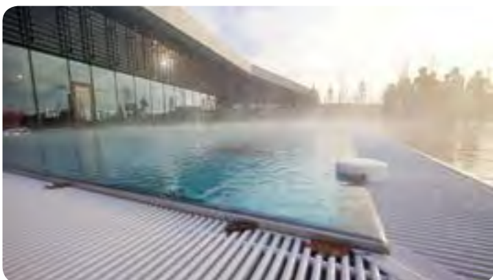
Sourcéane, le Centre aquatique du Douaisis, à Sin-le-Noble, dans le département du Nord. Sur cette photo on se rend compte du brouillard généré par la différence de température entre l'eau du bassin chauffée à 28°C et l'ambiance extérieure.
