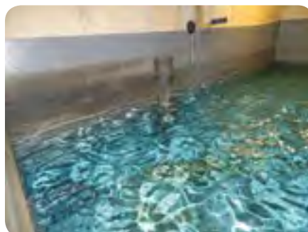
Le bac tampon mal entretenu est un réservoir magnifique.
