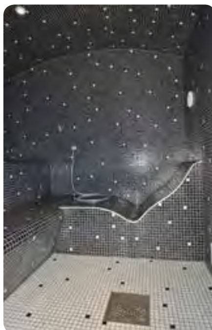
Le hammam est pourvu de spots IP65 et d'un éclairage en fibre optique pour reproduire l'effet d'un ciel étoilé
