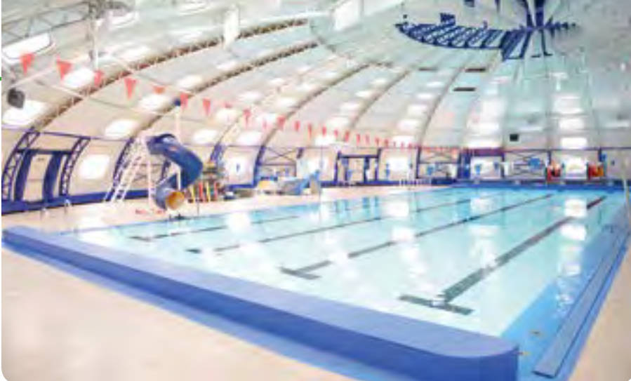
Rénovation de la piscine municipale Jacques MAGNIER à Clermont-Ferrand (63) par membrane armée du bassin de 25 x 10 m. Couleur du revêtement : bassin en blanc, abords et goulottes en antidérapant bleu marine, lignes de nage en noir. RPC
