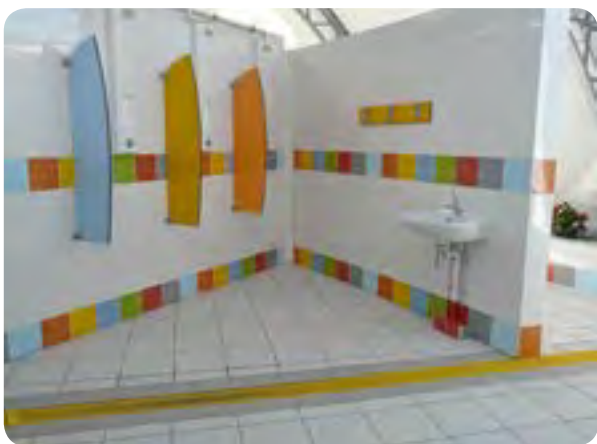
Des vestiaires spacieux et agréables ont remplacé les anciennes structures préfabriquées.
