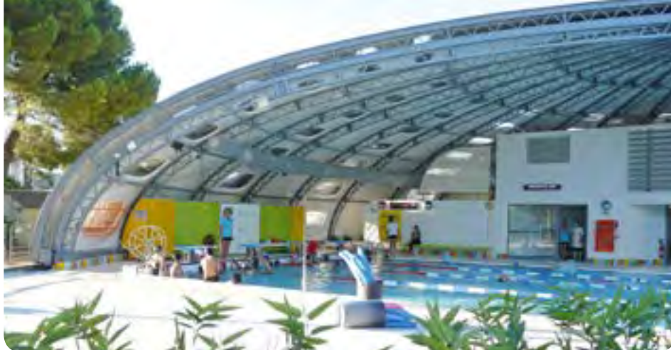
Sur la gauche (en partie fixe de la structure), on distingue la gaine de ventilation située à environ 3,50 m du sol.
