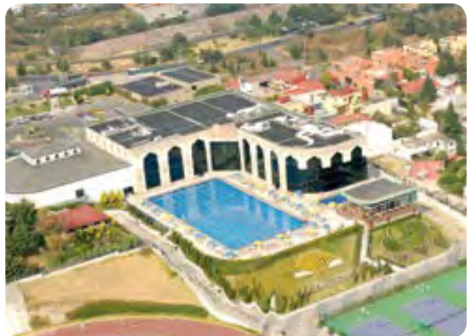
Mexique - 780 panneaux solaires, systèmes de préchauffage pour un centre sportif local
