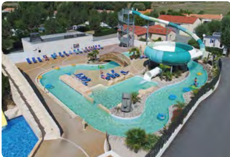
La nouvelle rivière à bouées installée au Camping Le Bois Joly à St Jean-de-Monts (85)
