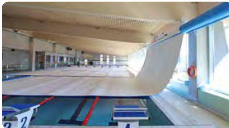
Piscine de San Lorenzo in Banale (TN) : 12,5 x 25 m. Couverture isotherme en mousse Corex65 à enrouleurs motorisés modèles STP fixés aux poutres du toit.
