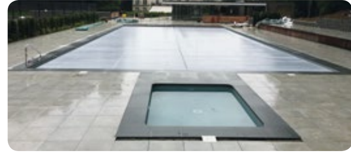
Double couverture installée au Club Bruxellois sur une piscine de 12,50 x 27 m
