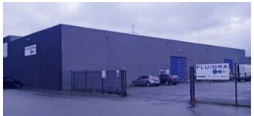
Nouvelle agence Fluidra en Flandre à Temse
