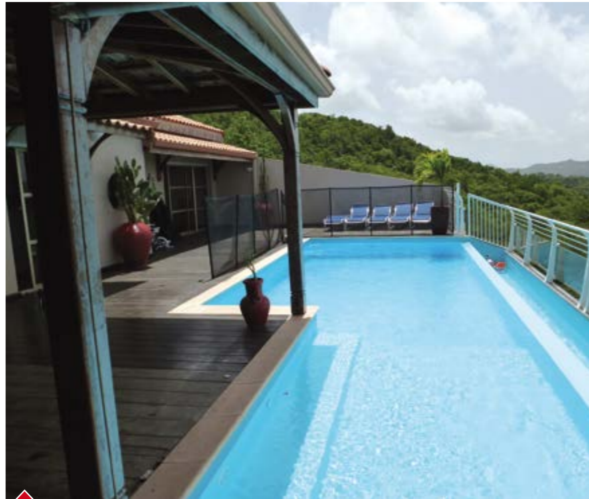
Exceptionnelle construction avec un débordement de 9,50 m sur un dénivelé de 7 m. Dimensions : 10 m X 5 m/3 m, volume 70 m3. Béton armé, membrane armée 150/100e (Alkor vert caraïbes), filtre sable (Triton) et pompe 1,5 cv (Ultra Flow), électrolyse du sel (Ecosalt), chauffage PAC (Zodiac). (Piscines Brion – Ste Luce – Martinique)
