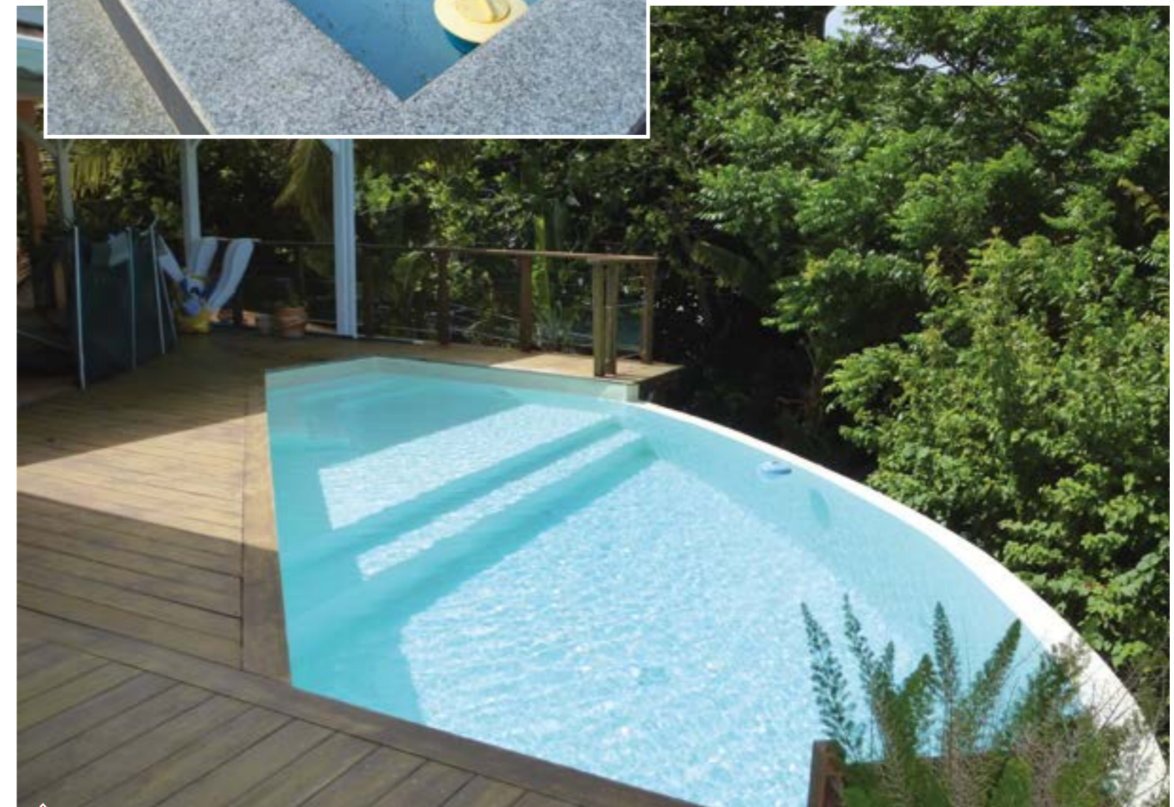
Dans un terrain en pente, face à la mer, une piscine intégrée à la maison. Bassin béton armé (débordement sur 1 côté), membrane 150/100e (Alkor sable), chauffage PAC (Hayward). (SAD + J.Y.Deblaine/Maçonnerie – Baie Mahault – Guadeloupe)
