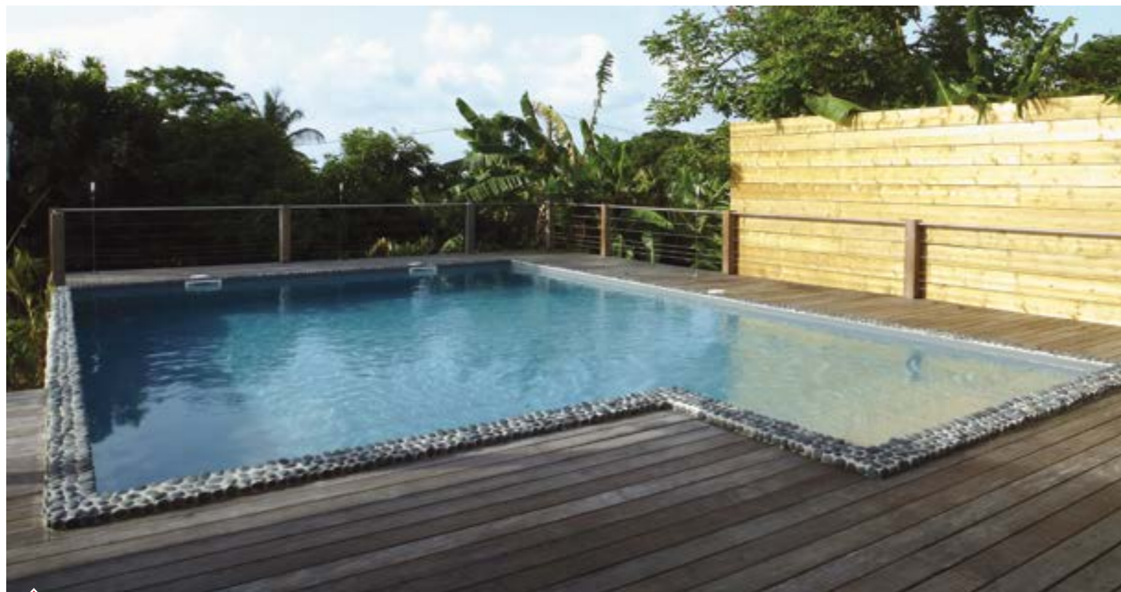
Ici, la cliente voulait une margelle en galets. Bassin béton armé, membrane armée 150/100e (EL.B.e gris anthracite), filtre sable, électrolyse du sel (FMP). (Lamentin Piscines – Baie Mahault – Guadeloupe)
