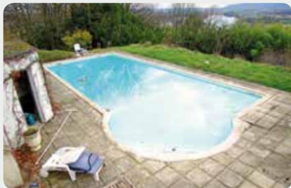
*Così stondata, la scaletta della piscina non si adatta al montaggio di una tapparella galleggiante automatica che riveste completamente lo specchio d'acqua.*
