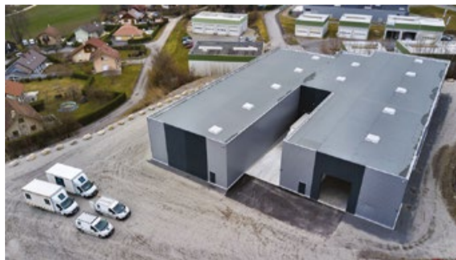
Le nouvel entrepôt de 1 600 m 2
