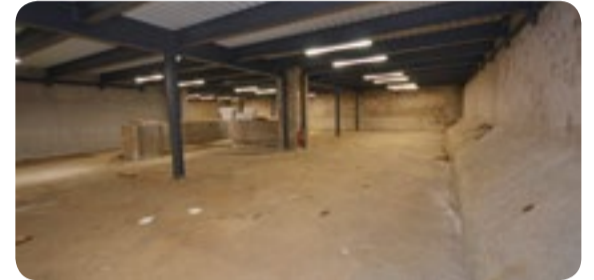
Le fond de l'ancienne piscine (5 m de haut) qui supporte le nouveau bâtiment va être aménagé pour stocker les matières premières et produits finis
