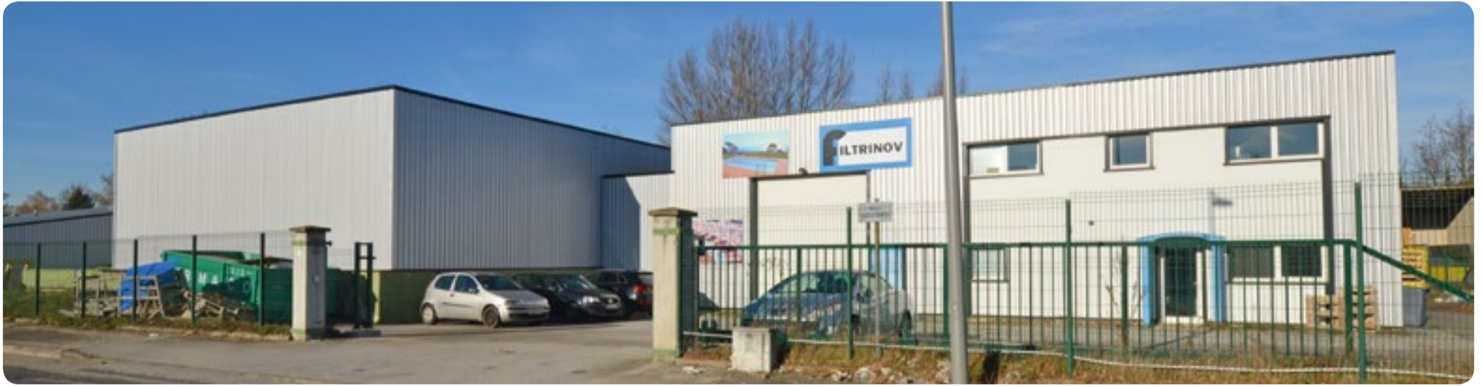
L'extension (2 x 400 m 2 ) visible, à gauche du bâtiment original / Der Erweiterungsbau (2 x 400 m 2 ) ist rechts neben dem ursprünglichen Gebäude sichtbar L'estensione (2 x 400 m 2 ) è visibile, a sinistra della costruzione originale
