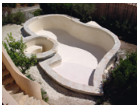
Bassin monocoque béton, coulé en une seule fois. Un enduit ciment hydrofuge complète l'étanchéité qui devient ainsi un revêtement de finition. (Leader Pool)
