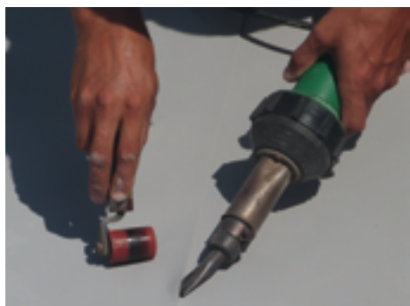
Pose membrane armée Alkorplan 150/100° Gris Clair - Utilisation Roulette de pression + Leister (Annonay Productions France)
