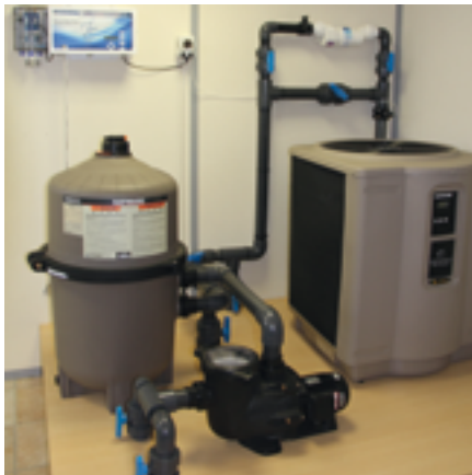
Show room - Montage pompe, filtre, électrolyseur de sel, pompe à chaleur
