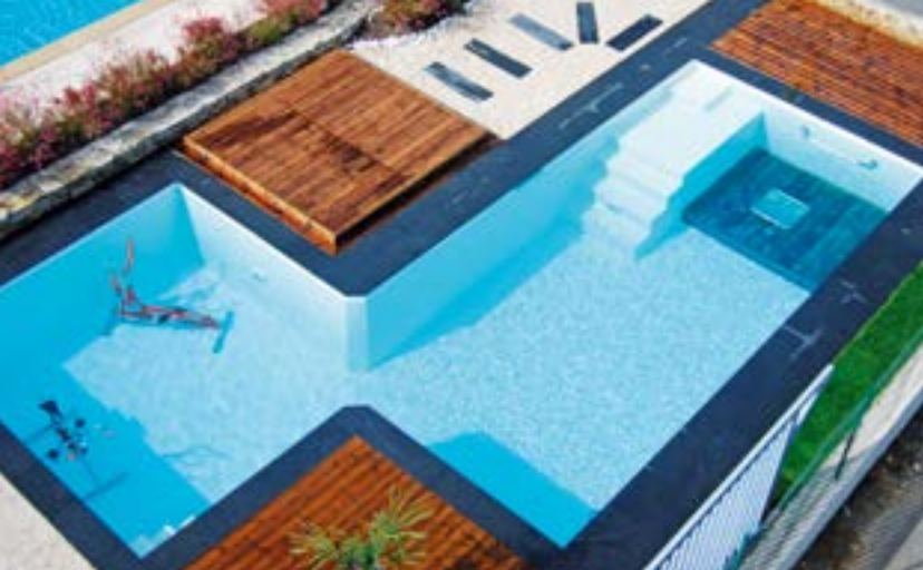
Vue aérienne de l'installation
