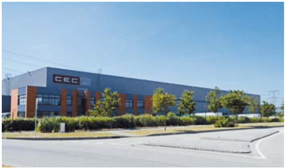
Siège de CEC à Saint-Quentin-Fallavier (38)
