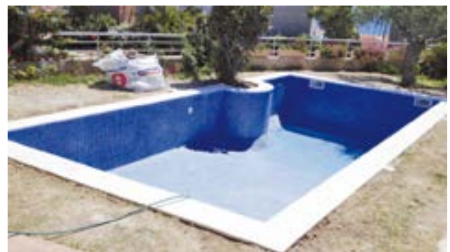
Pose de la margelle, jointement et filtration
