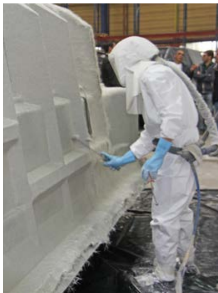
Une fois la mise en place du système de renfort de la coque, nouvelle opération résine/fibres par le robot et débublage manuel
