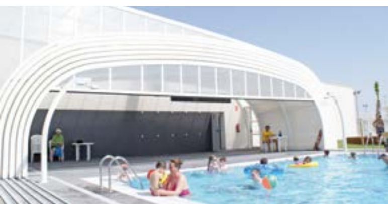
Vega Star télescopique, 14 m de large x 27 m de long à Murcie (Vegametal)
