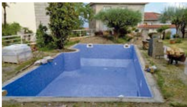
Pose du revêtement mosaïque
