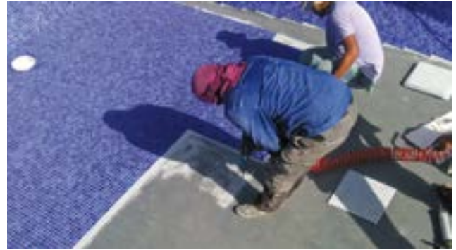
Installation de la membrane de PVC thermo soudée
