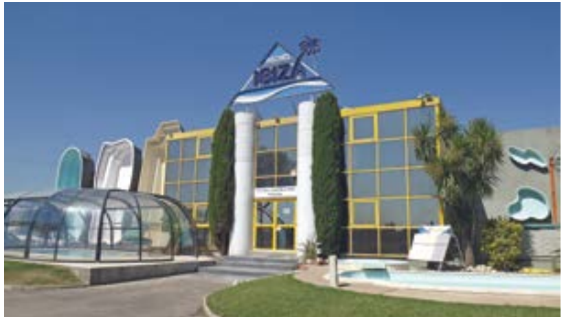
Piscines Ibiza - Siège, bureaux et usine à Pia (66)
