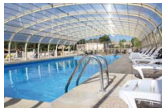
Vega Line Deslizante Extra, 16 m de large x 24 m de long (Vegametal)
