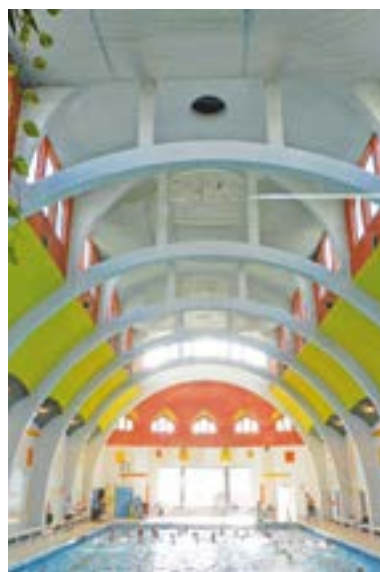
Espace piscine avant rénovation
