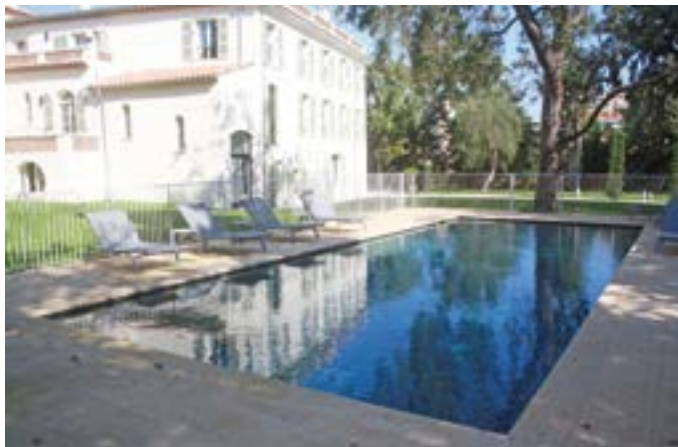
Piscine 12,0 x 6,0 x 1,5 béton + mosaïques noires brillantes, conçue et réalisée par SWIT, à Antibes
