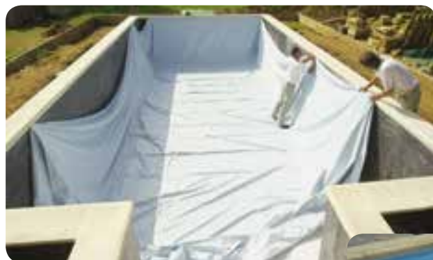
Pose de liner chez Mondial Piscine
