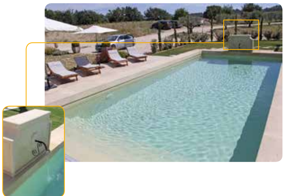
La piscine de 9 m x 4,50 m avec sa chute d'eau rustique raccordée aux refoulements de la filtration
