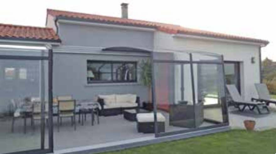
Abri de terrasse à pans coupés. Structure en aluminium complétée par un vitrage
