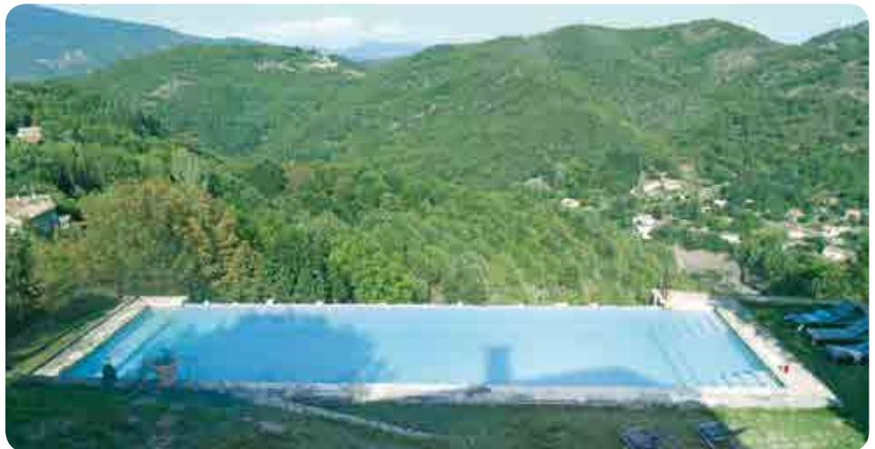
A Jaujac (07), une réalisation paysagère Audigier Piscines 19 m x 6 m, membrane armée gris clair (y compris pièces à sceller), débordement de 17m avec bac tampon sous piscine
