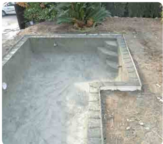
Projection béton (gunité) sur ferrailage en place et blocage arrière (terre) avec nappe / bambous (Piscines Diffazur)
