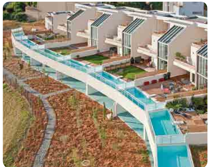
Les piscines de la résidence Horizon 220 à Nice sont équipées des blocs Filtrinov
