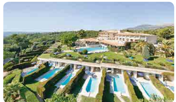
Les piscines du MAS D'ARTIGNY Hôtel & Spa à Saint-Paul-de-Vence sont équipées des blocs Filtrinov
