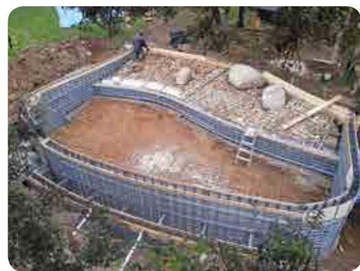
Le coffrage original de Piscines Marinal permet toutes les formes
