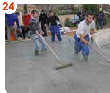
19 - Gérard HOUDIARNE (formateur BP) est venu assister les élèves à la pose de la membrane armée.
