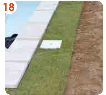
18 - Remblaiement et pose du gazon en rouleau.
