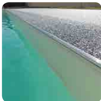
Ici, la plage de piscine vient s'appliquer jusqu'en bordure du bassin
