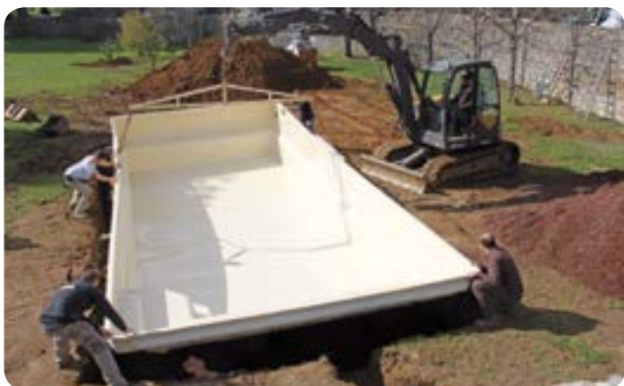
Mise en place avec un engin de levage. On aperçoit côté grand bassin le logement moulé du futur volet roulant.
