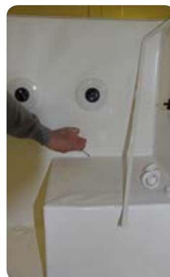
Contrôle soudures de la membrane armée
