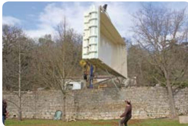
Passage de la coque par le mur de la propriété.
