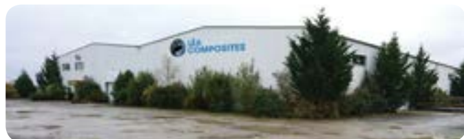
Usine de La Gravelle (53)
