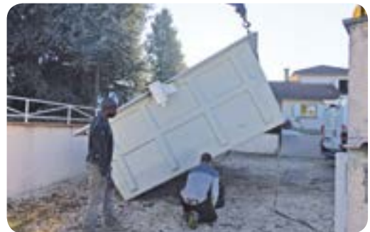
La piscine transportée verticalement sur la remorque doit d'abord être mise à plat pour la reprendre horizontalement avec les élingues.
