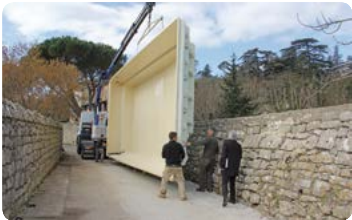
Transport vertical de la coque dans cet accès étroit.
