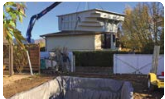
La grue du camion peut alors déplacer horizontalement la piscine vers le chantier où l'attend le terrain préparé : la fouille a reçu un géotextile sur les parois pour éviter que le gravier de remblaiement n'entre dans la terre, assurant ainsi une meilleure stabilité de l'ouvrage.
