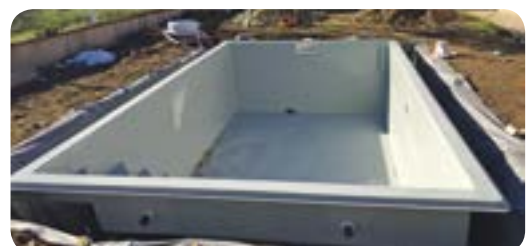
Bien mise en place, la piscine sera remblayée avec un gravier concassé 6/10.
