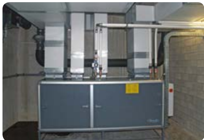
Exemple d'installation de déshumidification
