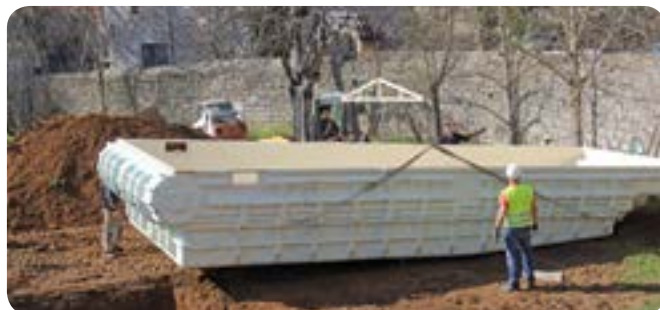
Transport vertical de la coque dans cet accès étroit.
