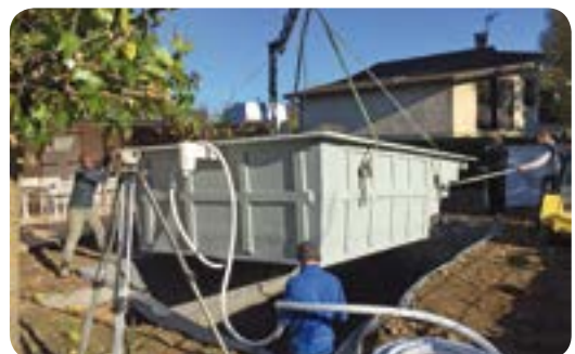
Après vérification des niveaux, on peut alors descendre la coque (on voit ses renforts).
