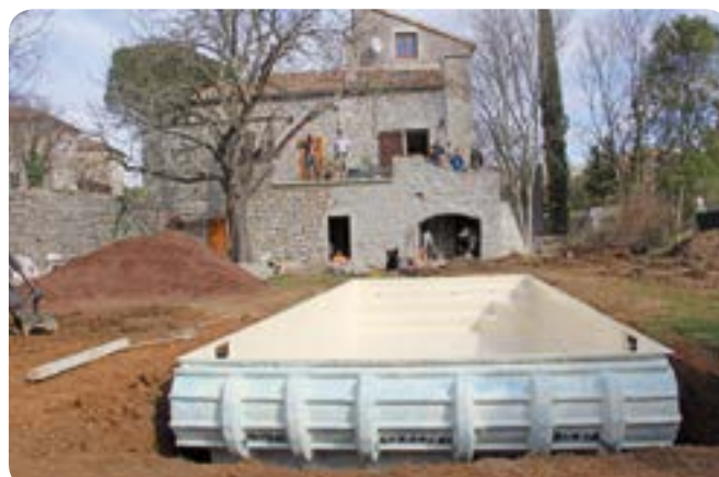
Piscine en place. Au fond, un tas de graviers rouges de pouzzolane (régional), excellents remblais pour la piscine.
