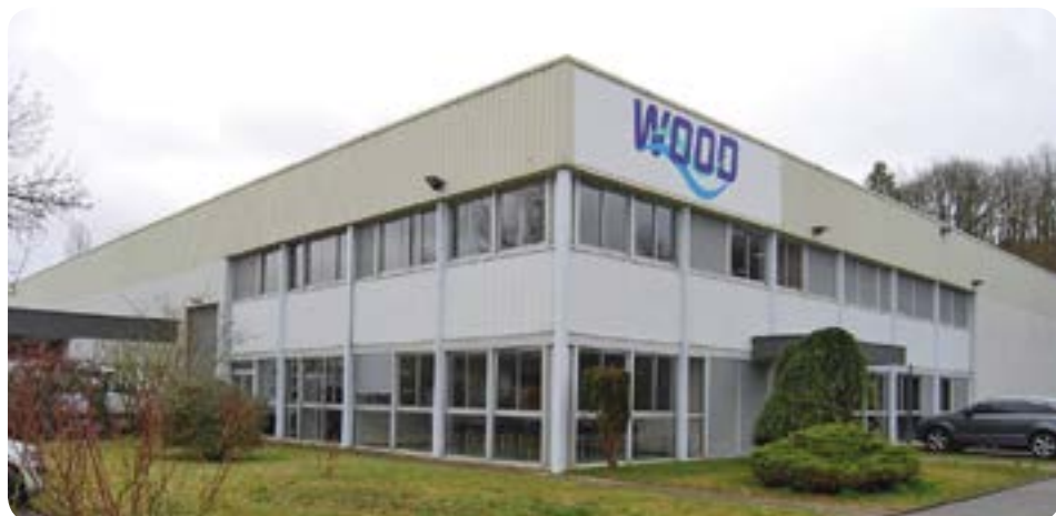
Usine de production de 4 200 m 2 située à Dourdan (91)
