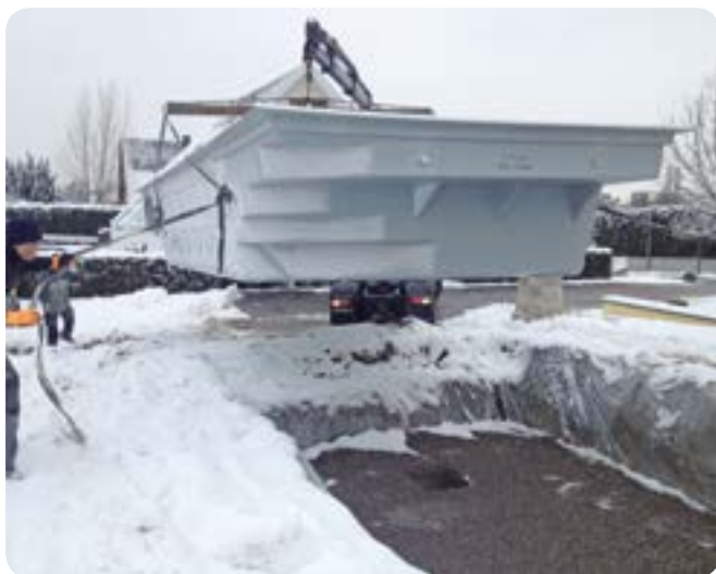
En Alsace, chez Pool 68/Sadifel, mise en place d'une coque Mediester dans la neige
