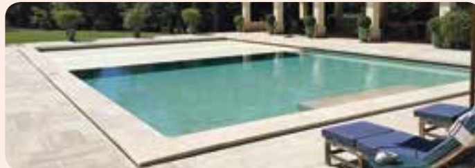
Montage en banquette immergée sur piscine de 15 x 9,5 m de large avec débordement sous margelle. Réalisation Espace et Eaux (30)
