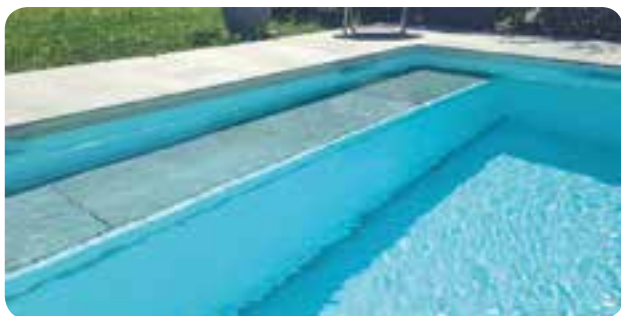
Couverture automatique avec caillebotis immergés
