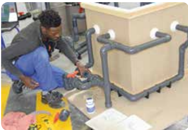
Alexis UGUEN, en cours de montage de l'hydraulique (PVC pression/AstralPool).
