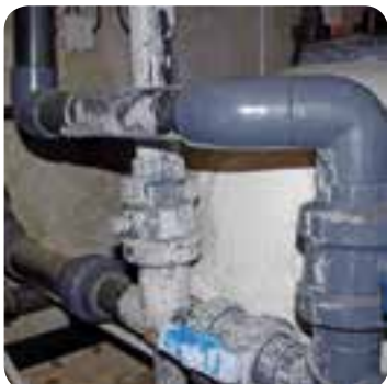
Dépôt de calcaire causé par une fuite sur un réseau hydraulique
