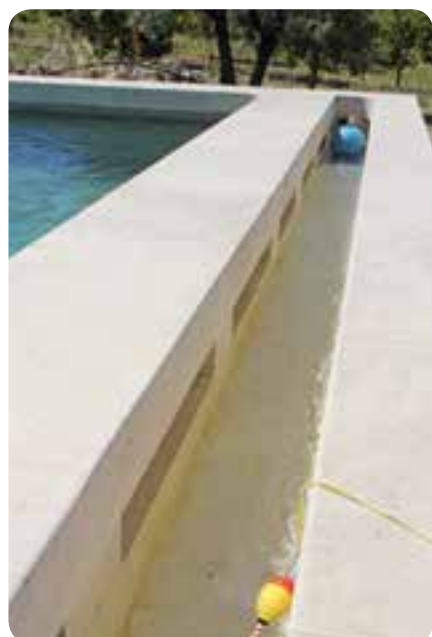
La goulotte avec ses sorties de skimmers. En fond, le flotteur du régulateur de niveau d'eau
