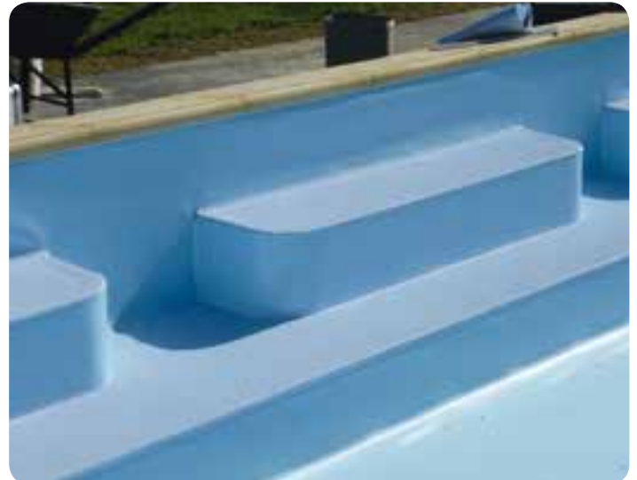
Réalisation délicate de 3 escaliers avec membrane armée - Delifol
