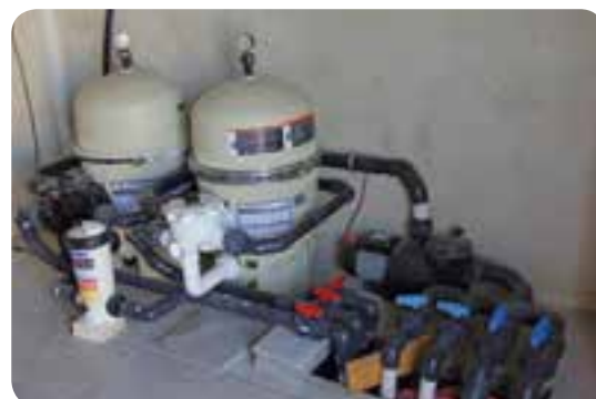
Au local technique, 2 filtres à diatomée et chlorinateur / galets
