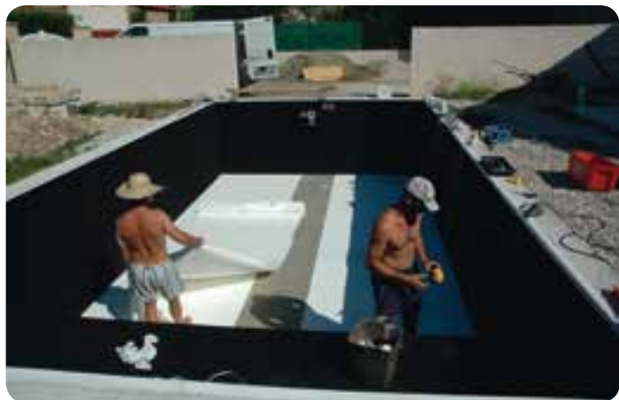
Pose achevée du feutre de protection sur les murs en blocs isolants polystyrène
