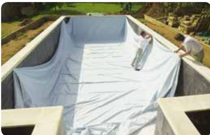
Pose d'un nouveau liner
