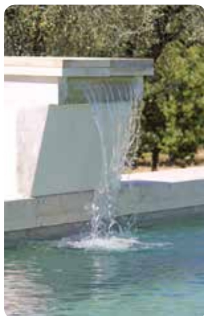
La chute d'eau est dérivée du circuit de refoulement
