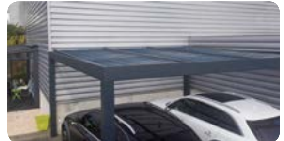
Carport solaire e-Rcar
