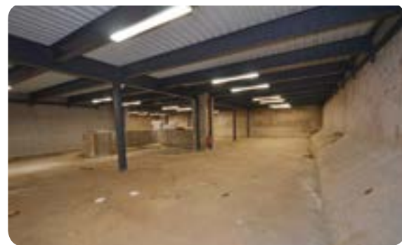
Le fond de l'ancienne piscine (5 m de haut) qui supporte le nouveau bâtiment va être aménagé pour stocker les matières premières et produits finis
