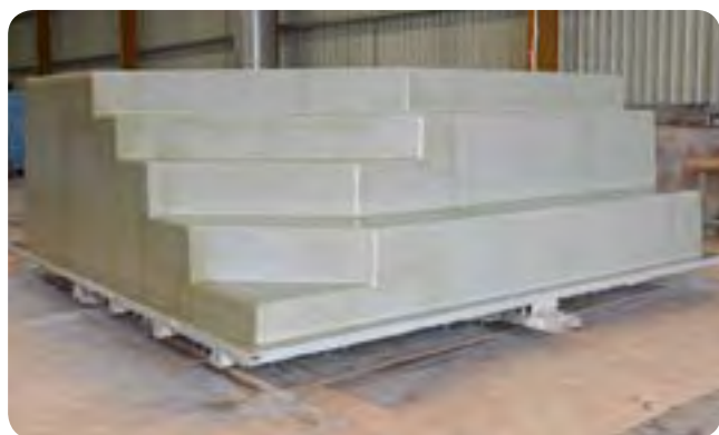
Application des couches de mat de verre + résine terminés avant positionnement des renforts en acier galvanisé
