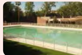
Barrière de sécurité (Axium)
