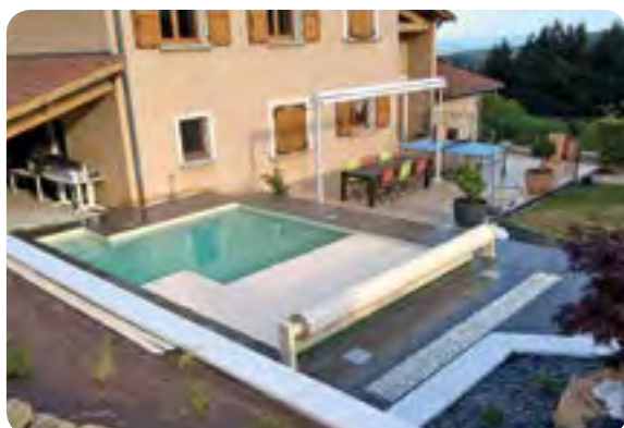
Piscine 6 m x 4 m, fond plat 1,45 m, volume d'eau 32 m 3 , coffrage perdu béton + ferrailage (Structura Feat), membrane armée, volet roulant hors-sol - Réalisation : EVML piscine Everblue (69)
