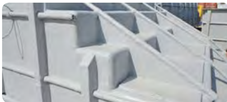
Piscine terminée, aperçu des renforts et sur les marches auto porteuses
