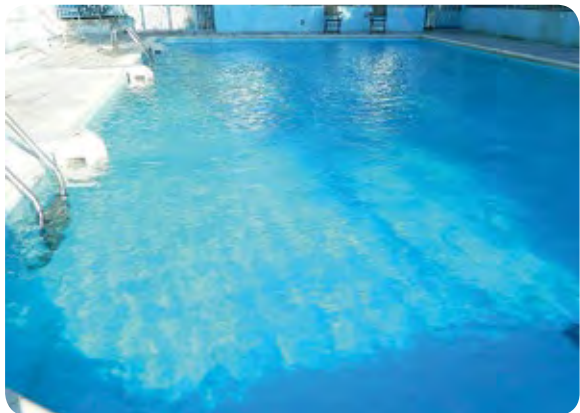
La piscine rénovée équipée des 3 monoblocs de filtration
