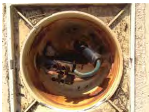
La rouille sur les dominos indique une présence d'eau dans la boîte de connexion
