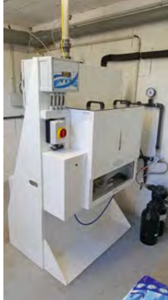
Installation du générateur de chlore in-situ Syclope à la Piscine Municipale de Billère (64)
