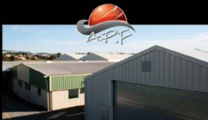
Unité de fabrication de couvertures isothermiques et d'hivernage de sécurité filtrantes Implantation : Annonay (07) Superficie couverte utilisable : 2500 m 2
