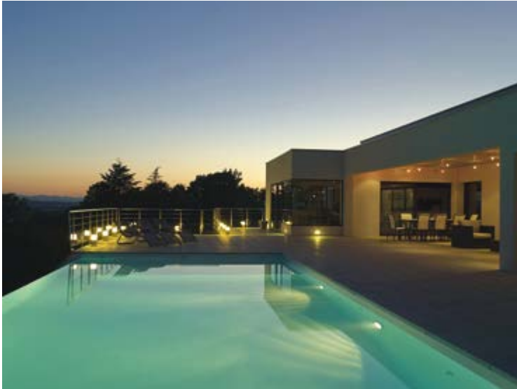
Piscine blocs à bancher + membrane armée 150/100 e , 13 m x 5 m, 2 filtres / 2 pompes, électrolyse du sel + réglage pH Couverture sécurité (Rollenergy) / débordement côté (Piscines Pyrénées Construction / Carré Bleu - 64)
