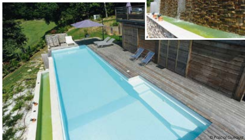
Piscine blocs à bancher + résine polyester armé (gris clair) 13 m x 4,2 m / 3,5 m, volet immergé, électrolyse du sel + régul pH, nage à contre courant, mur du débordement en Pierre des Pyrénées - Plage / caillebotis pin, pompe à chaleur (16 kW) (Eden Pool / Piscines de France - 40)
