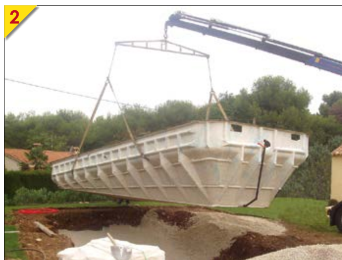
Mise en place après terrassement et assise du fond en gravier
