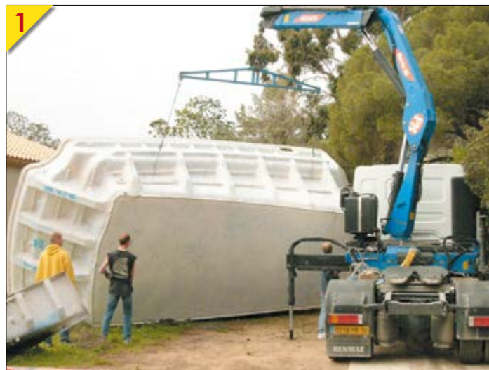
Déchargement avec le camion grue à l'aide d'un palonnier et élingues
