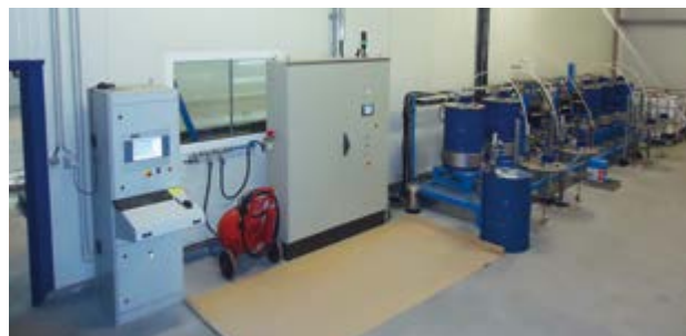
Poste de pilotage informatisé
