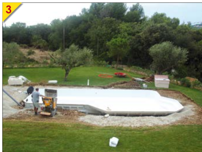
Remblaiement en matériaux de carrière compactables
