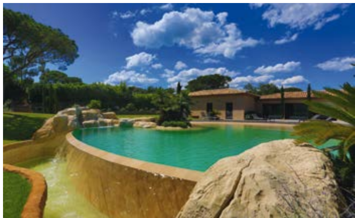
Piscine béton projeté, revêtement Crystalroc sable 13 m x 8 m x 4,50 m, profondeur 1,20 m / 2 m, plage immergée, rochers reconstitués (Diffaroc) nettoyage Diffaclear (Piscine Diffazur / ADC - 83)
