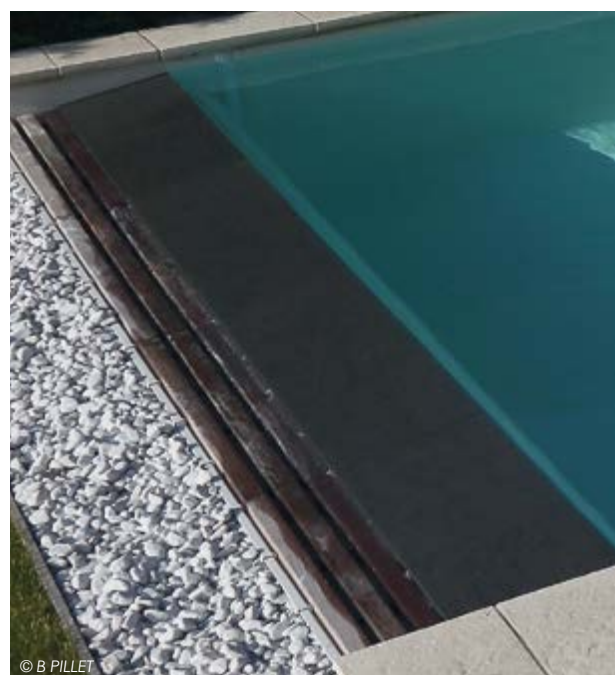
Piscine 8 m X 4 m, fond plat 1.50 m, membrane armée, débordement sur largeur (procédé O-ViVa) (Virginia Piscines - Les Jardins Verts et Bleus - 01)
