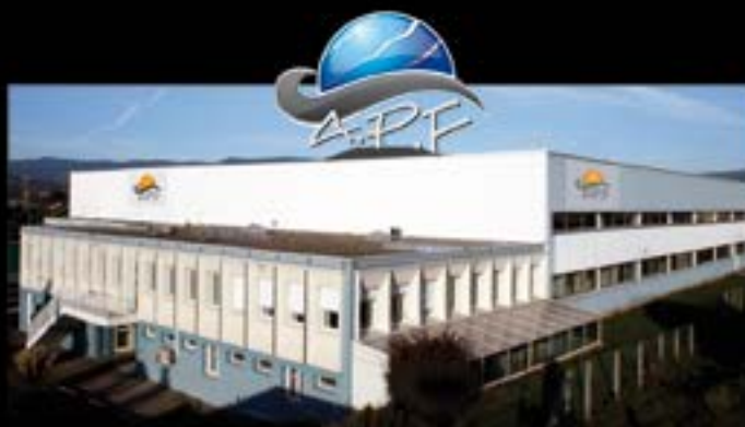
Unité de fabrication de liners et de couvertures d'hivernage de sécurité opaques Implantation : Annonay (07) Superficie couverte utilisable : 6500 m 2
