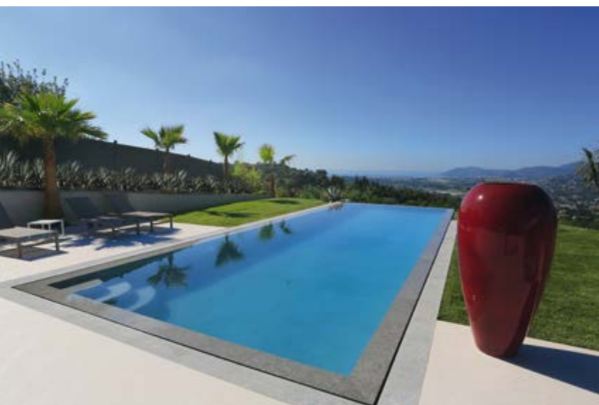
Piscine béton projeté, revêtement Crystalroc Impérial gris 12m x 3 m x 5 m, profondeur 1,40 m - 1,50 m, filtration sable 22 m³/h (Triton), traitement Diffapur, débordement 2 côtés (Piscine Diffazur / SLV - 06)
