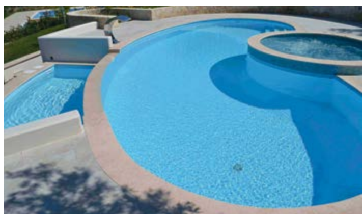
Piscine et spa béton à débordement. Procédé Leader Pool (Master Pool - Grèce)
