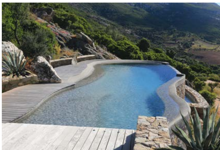
Piscine béton projeté, revêtement Crystalroc Impérial gris 12m x 6 m, profondeur 0,90 m à 1,80 m - plage immergée, nettoyage Diffaclean, traitement Diffapur (Piscines Diffazur / SLV - Calvi - 20)
