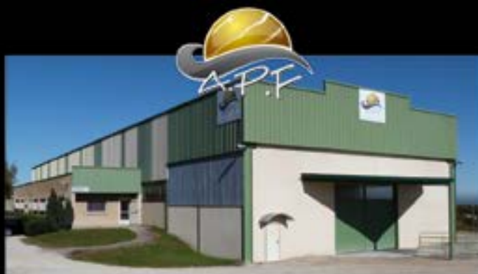
Plate-forme de stockage et distribution de matériel Implantation : Annonay (07) Superficie couverte utilisable 3000 m 2
