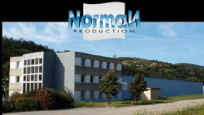
Unité de fabrication de couvertures de sécurité à barres Implantation : Annonay (07) Superficie couverte utilisable : 2500 m 2
