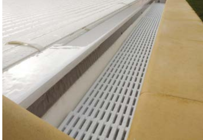
L'OverFloT permet de conjuguer le débordement et le volet (modèle breveté) (P.I.D. Escalé Premium)
