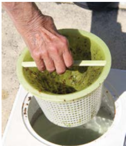
Panier de skimmer avec « sac filtrant » totalement colmaté
