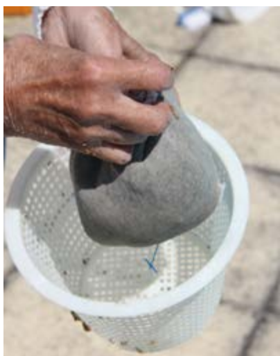
Le « sac filtrant » est retiré et remplacé par un neuf
