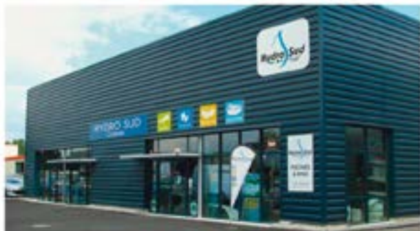
Le métier des professionnels indépendants Hydro Sud Direct : vendre, conseiller, installer, construire, rénover
