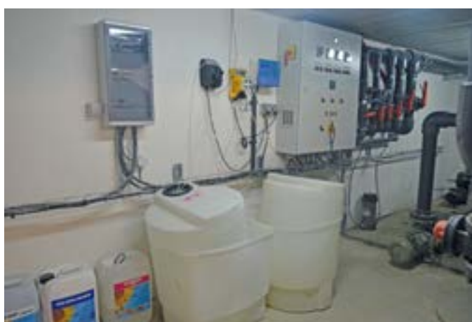
Traitement automatique Chlore/pH
