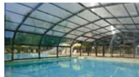
Abri fixe jouxtant le bassin de plein air Camping Le Vézère Périgord (24) (Sokool France)
