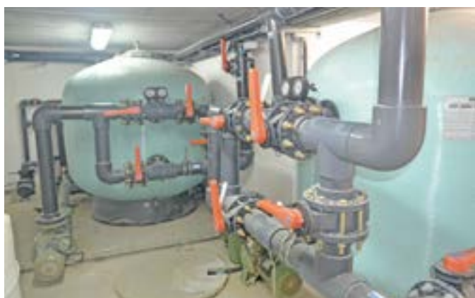
Local technique équipé de deux filtres Astral Ø 1 600 en batterie avec 2 pompes de 5 CV Tri
