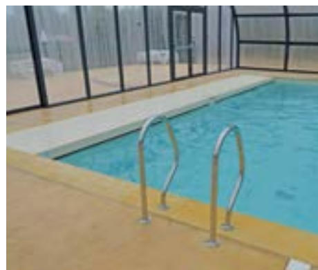
Débordement sur le côté pour un meilleur écumage de la surface. Bac tampon d'une capacité de 14 m 3
