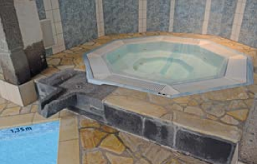
Cascade décorative avec reprise de l'eau de la piscine
