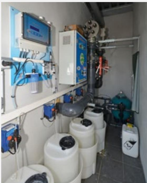
*Le manque de place dans le local technique nous a obligé à concevoir une installation confinée. Si la surface avait été plus importante, l'installation aurait été plus aérée et fonctionnelle (panneau de traitement AVADY (fournis par SCP) et déchloraminateur UV GERMI).*
