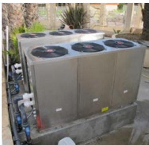
Deux GOA Pro 3 installées en batterie dans un camping, pour 2 bassins jumelés de 800 m<sup>3</sup> en tout, dont le plus grand a été équipé d'une couverture isothermique
