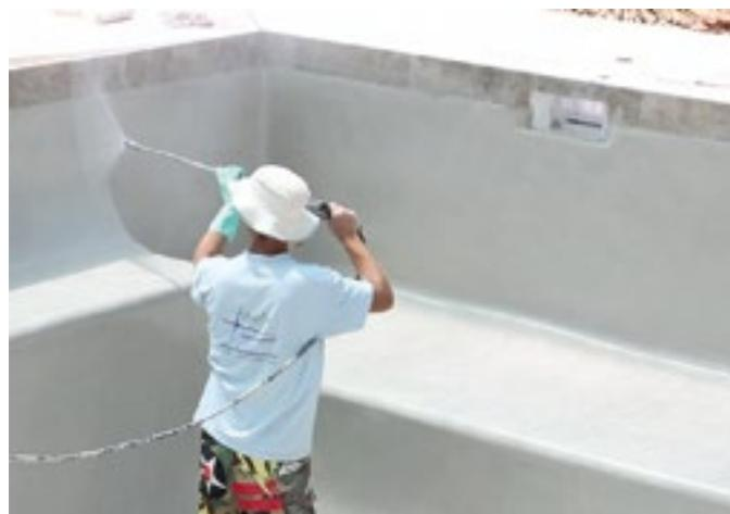
Sur un bassin entièrement neuf, il est possible d'exécuter le revêtement directement sur support béton brut sans hydrofuge, avec une économie de réalisation conséquente pour l'exploitant. Le revêtement au fini naturel peut aussi intégrer des logos, des motifs ou encore créer des variations colorées afin de souligner des frontières entre différentes zones de profondeurs d'eau par exemple.
