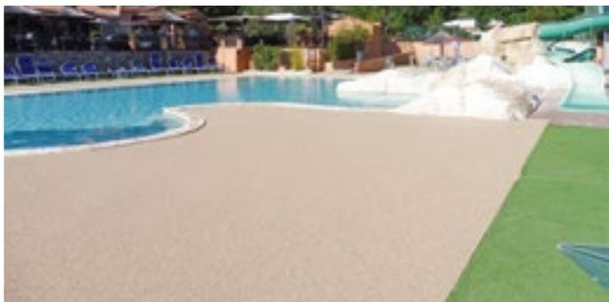
Ce concept de sol perméable ne nécessite aucune pente, aucune grille, ni caniveau ou autres dispositifs d'écoulement ou de captage des eaux de pluie. Seul un terrassement stable et perméable (graves d'empierrement soigneusement sélectionnées) est requis en guise de support préalable.
