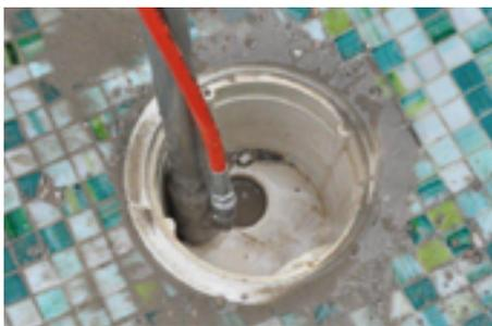
Pratique pour vidanger son filtre à sable, TYPHON peut aussi servir de simple aspirateur pour les débris et poussières, qui ressortiront sans poussière, étant mêlées à l'eau pulvérisée de l'appareil haute pression (de 180L/h à 400 L/h suivant les modèles). Idéal pour les eaux chargées de particules de boues, feuilles, sable, gravier, gros débris...
