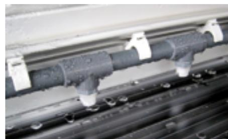
Une rampe de diffusion intègre des buses à haute pression, placées tous les 50 cm. Celles-ci nettoient efficacement le tablier et ses interstices. Saletés, feuilles, algues sont automatiquement chassées lors de l'enroulement et du déroulement de la couverture. CoverWash est un système dépendant du coffret électrique du volet AquaTop.
