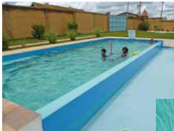
Il s'agit d'une piscine maçonnée de 10 m x 4,20 m (volume 45m<sup>3</sup> environ) de profondeur 1,10 m à 1,50 m. L'étanchéité/revêtement est assurée par une membrane armée Delifol
