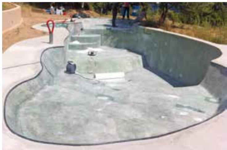
Le gros œuvre polyester (fibres de verre + résines et ponçage) est achevé prêt à recevoir la finition
