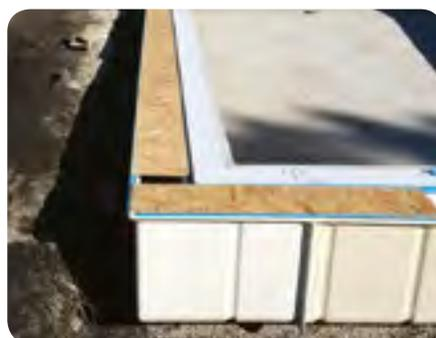
ISI-MIROIR avec remplacement d'entretoises par des plaques bois qui assurent un bon alignement des éléments de la goulotte et la propreté durant le chantier.
