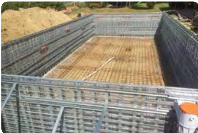
**MARINAL** : un procédé pour construction de piscines en béton armé banché monobloc, y compris en zone à risque sismique. Il est spécialement conçu pour être facile à mettre en oeuvre. MARINAL est présent partout en France à travers son réseau de distributeurs agréés. Mais également en Outre-mer (Réunion, Antilles) et à l'international (Espagne, Italie, Maroc, Canada...).
