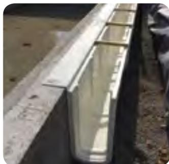
Pose du concept ISI-MIROIR sur maçonnerie avec entretoises provisoires en bois.
