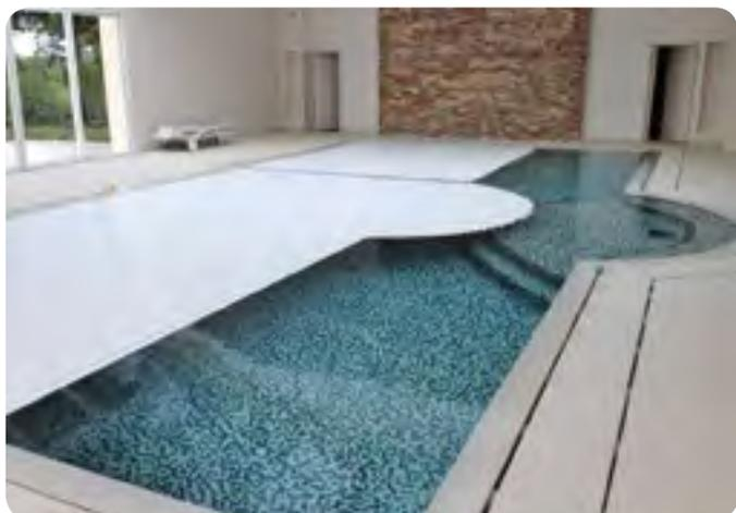
Couverture immergée Aquatop de T&A pour une piscine miroir (montage dans le mur)
