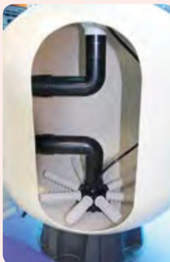
Avant de remettre un média filtrant bien vérifier l'état des crépines du filtre
