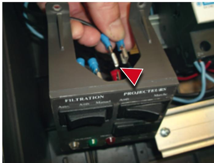
On repère aussi facilement l'interrupteur des projecteurs, dont on débranche les fils pour les schunter
