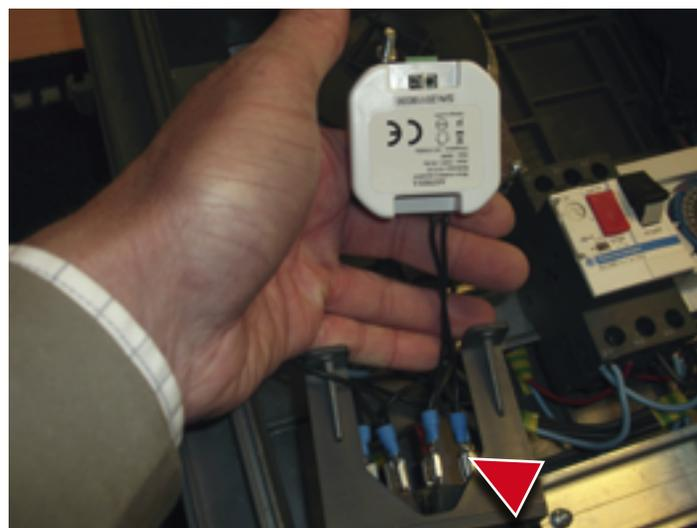
Et on vient raccorder les fils du récepteur sur l'interrupteur, peu importe le sens
