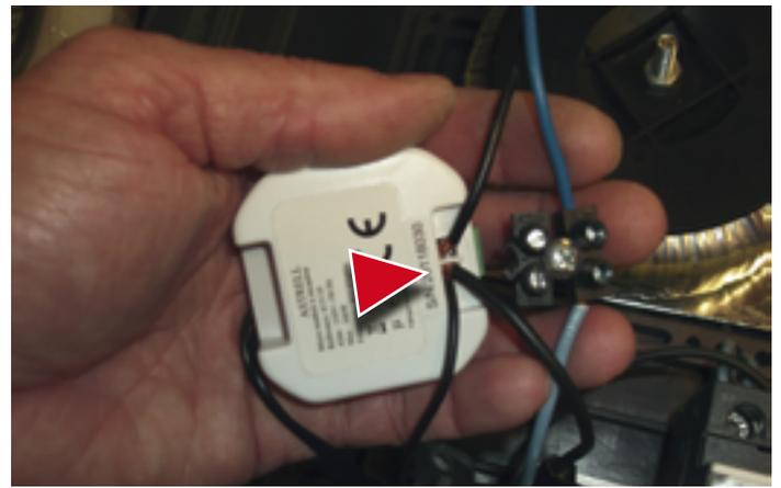
et on raccorde les fils aux bornes du récepteur.
