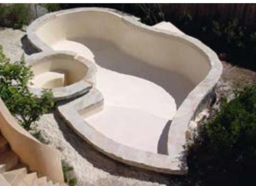
Bassin monocoque béton, coulé en une seule fois. Un enduit ciment hydrofuge complète l'étanchéité qui devient ainsi un revêtement de finition. (Leader Pool)
